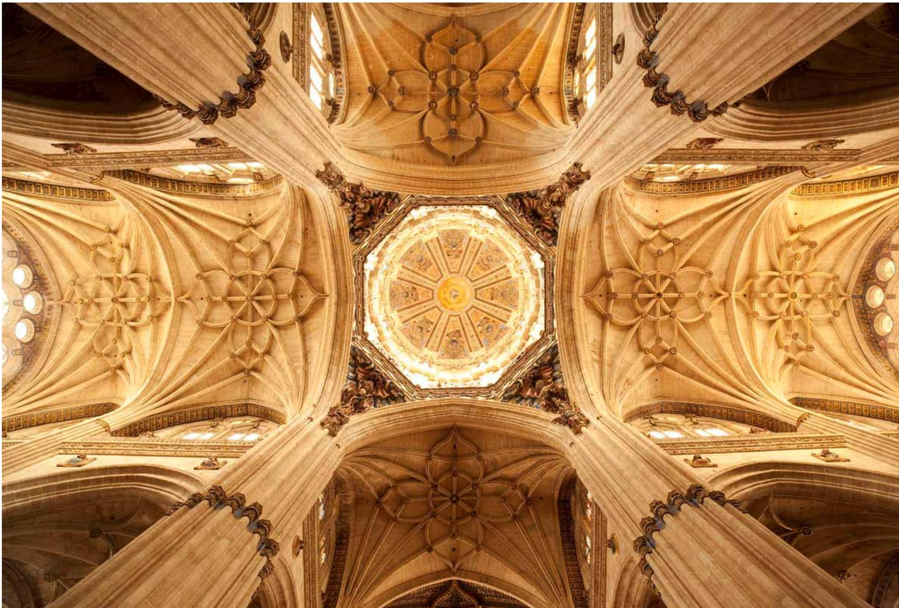
La restauración del cimborrio ha permitido recuperar la visión completa de todo su interior, el cual antes de la intervención estaba cerrado mediante una malla horizontal, colocada a la altura del barandal interior, que recibía los elementos que se desprendían de la superficie interna de la cúpula.
