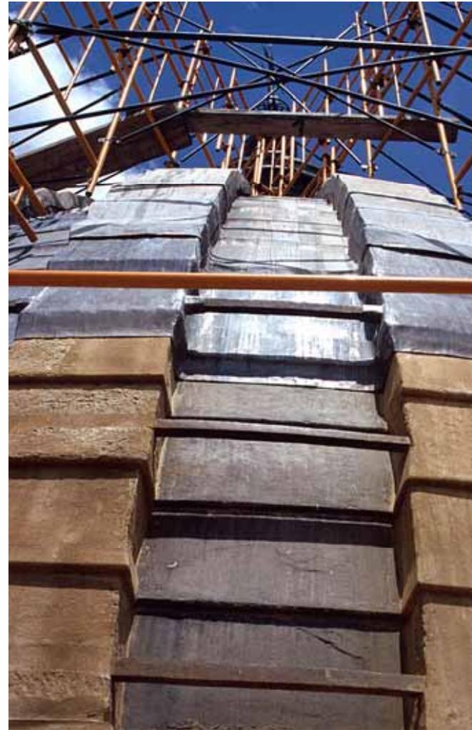
Descendiendo al nivel de la cúpula, aparece la masa semiesférica recubierta exteriormente en los dos tercios superiores de planchas de plomo engatillado sobre las que se repitieron las labores ya expuestas para la falsa linterna. Los cinchos de hierro forjado que absorben las tensiones de tracción de los paralelos inferiores, son magníficos ejemplares que fueron objeto de una revisión cuidadosa templando las cuñas de apriete.
