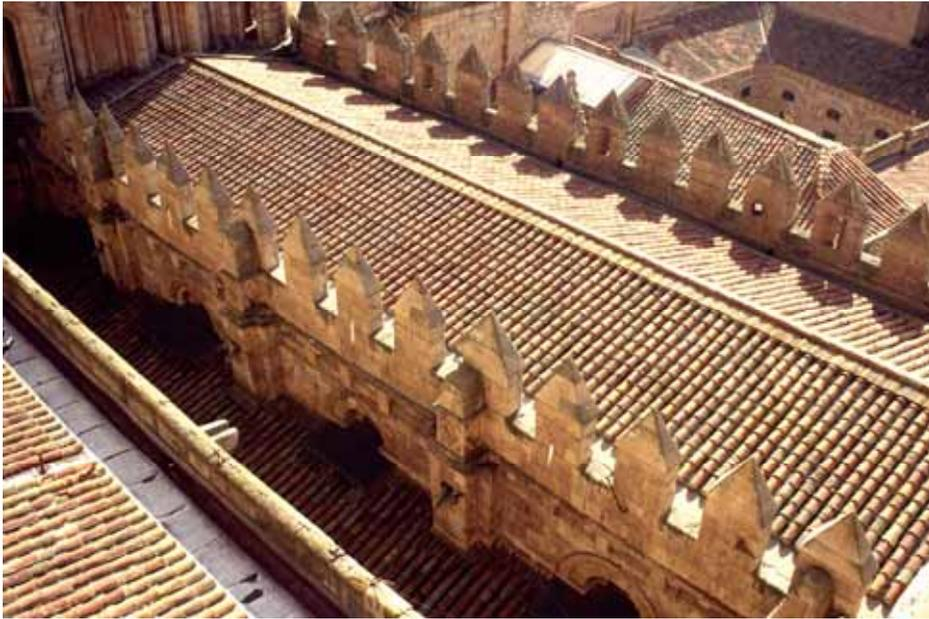
En 1988 también se realizaron las obras de reparación de las cubiertas de madera situadas sobre las bóvedas de las capillas de Santa Catalina y de Anaya en el claustro, que se encontraban colapsadas por pudrición y xilófagos. La reparación consistió en la sustitución de los elementos lesionados con nuevas estructuras de madera con secciones y soluciones constructivas idénticas a las originales.
