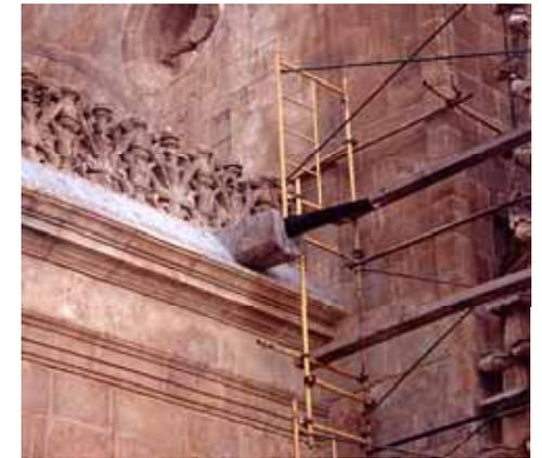
Se actuó sobre arbotantes, contrafuertes y pináculos, algunos de ellos severamente deteriorados, con desmontaje y reposición parcial de los sillares. Los paramentos fueron rejuntados y se procedió a su limpieza, con respeto de la pátina natural que le confiere la tonalidad característica.
