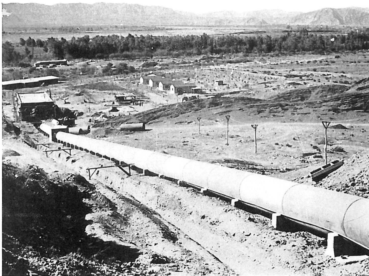
Panorama de la central en construcción
