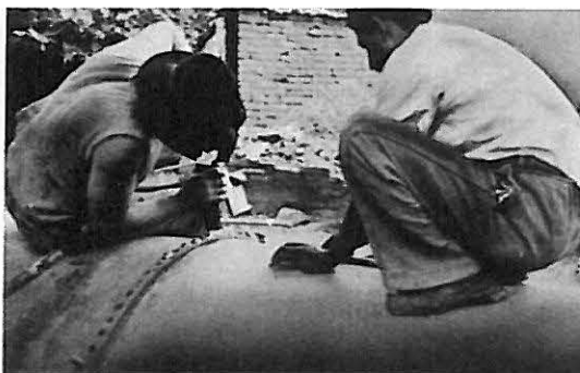
Remachando una junta de la tubería.
