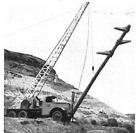
Izando un poste de 5 ton. de peso.
