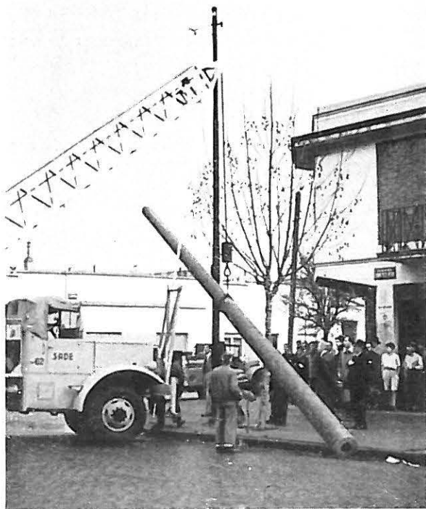
Las distintas fases de montaje de los sostenes y de la línea de contacto.
